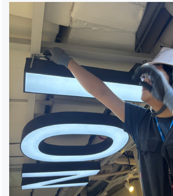
진동안전 점검 - 등기구 고정상태 점검
